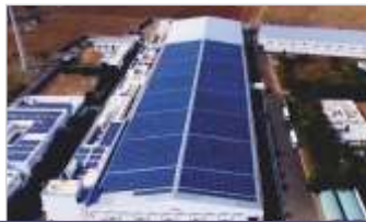
1000KWp SRG Apparels Tamilnadu
